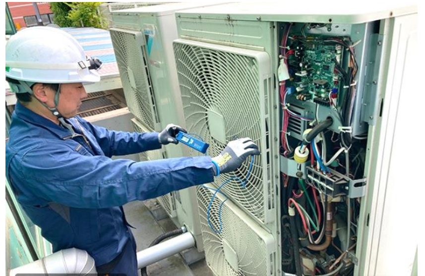
法定点検実施中
